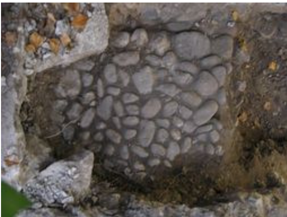
Illustration 11: Gatubeläggning av kullersten.
